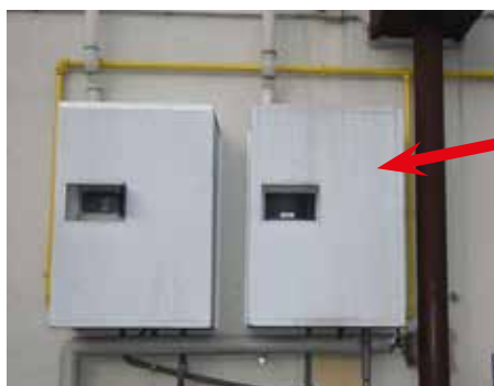
L'impianto di riscaldamento della Materna Est e, nel dettaglio, le due caldaie a gas rivestite da pannelli isolanti
